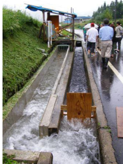
上写真：石徹白集落に作られた発電用らせん型水車 下写真：右側の農業用水路に水路を設けて発電する
