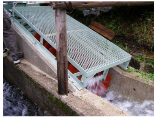
上写真：石徹白集落に作られた発電用らせん型水車 下写真：右側の農業用水路に水路を設けて発電する
