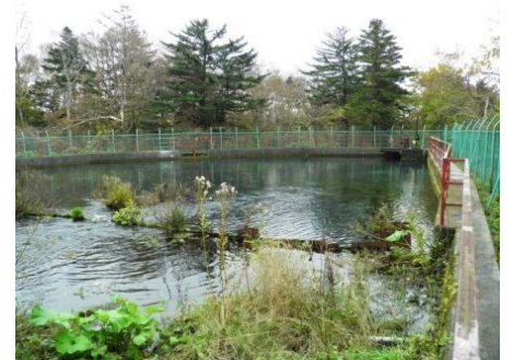
清川発電所の導水管(上)と水源(下)
