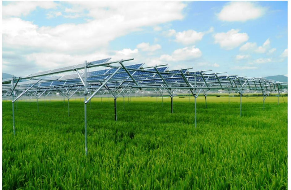
合原有機農園の水田に建設されたソーラーシェアリング発電所
