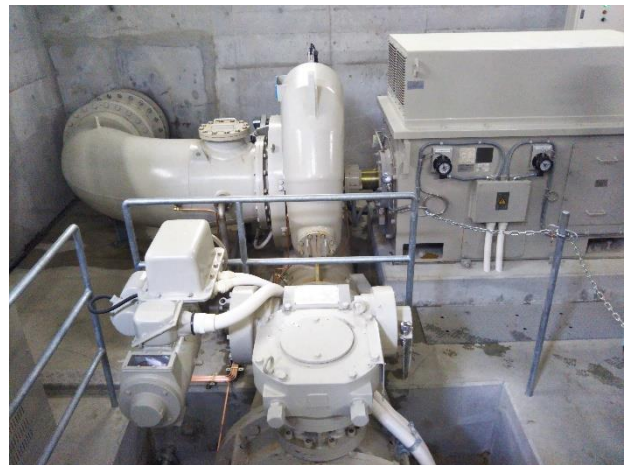
パイプを通して落ちる水の勢いで水車が回り発電する
