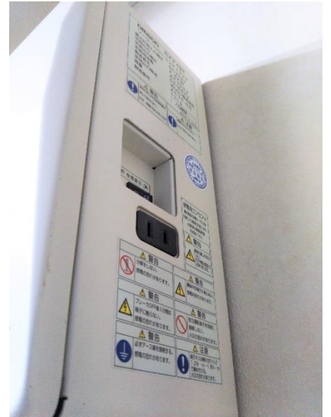
(左上から時計回りに)自立運転モードに切り替えるパワーコンディショナー／側面にある非常用コンセント／自立運転モードへの切り替え手順を示したカード
