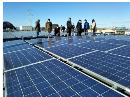
4号機のあるマンションと発電所
